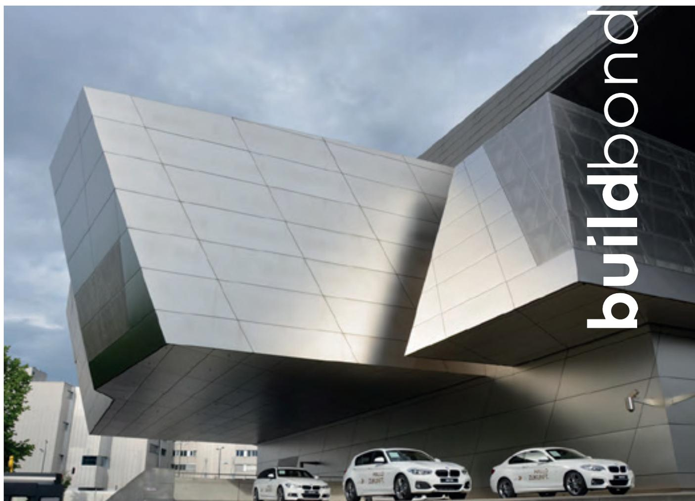
Buildbond A2 é um painel compósito, constituído por duas chapas de alumínio e um núcleo mineral incombustível, da classe "A2 - s1, d0", de acordo com a classificação da norma europeia EN13501-1.
