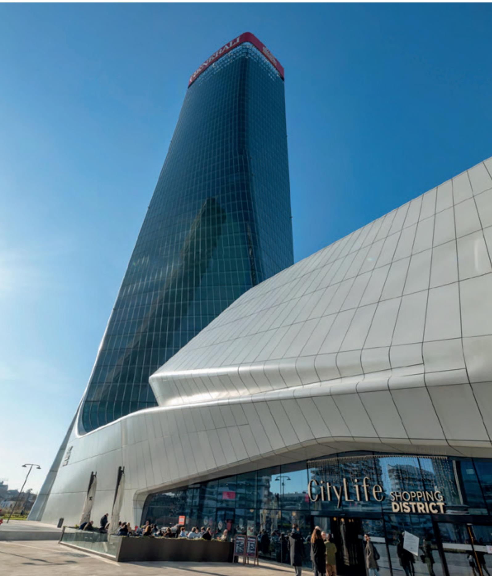
Buildbond PE é um painel compósito, constituído por duas chapas de alumínio e um núcleo interior de resinas termoplásticas (polietileno de baixa densidade).
