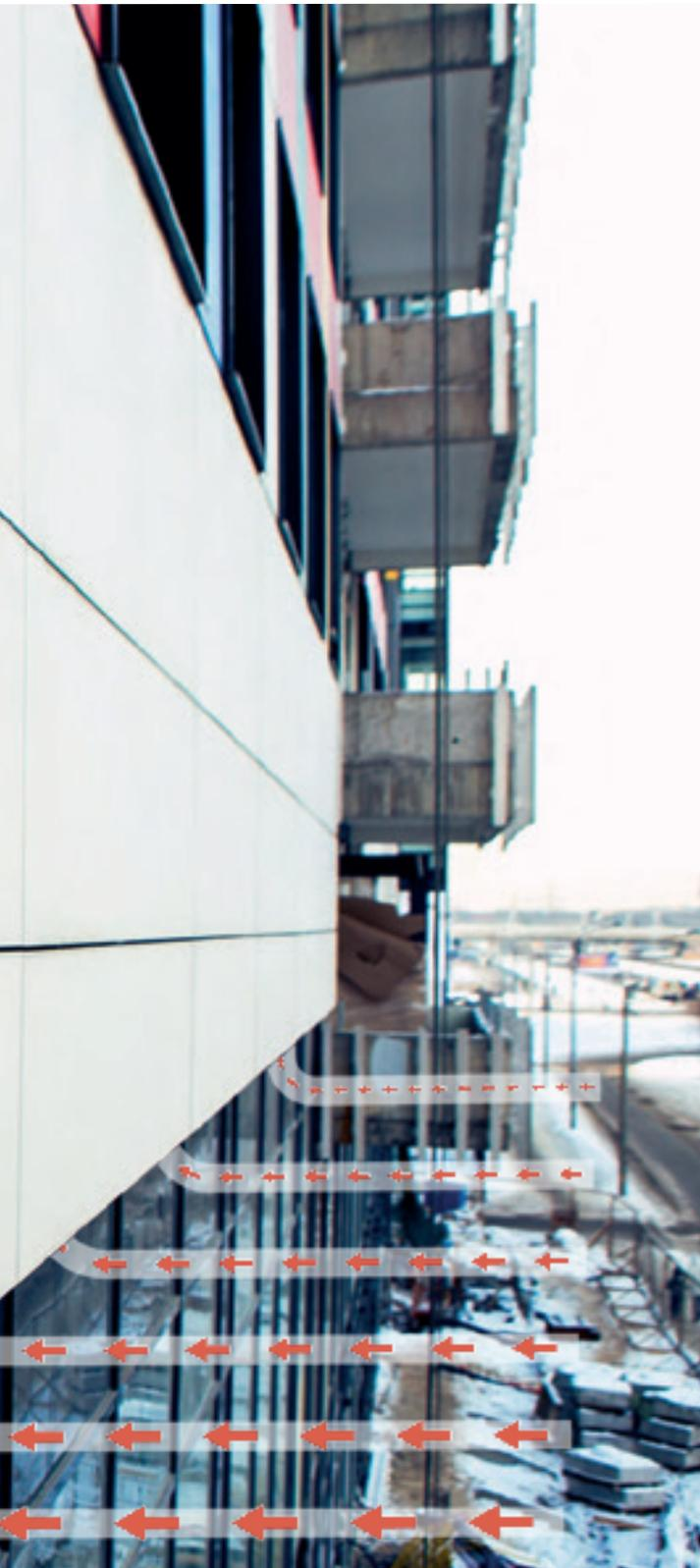
Los paneles Buildbond se aplican más frecuentemente en fachadas ventiladas, las cuales se consideran una solución constructiva sostenible, que alía innovación y eficiencia energética, dando lugar a una mejora del confort térmico, ya que son capaces de reducir entre un 30% y un 50% el consumo de energía de un edificio.
