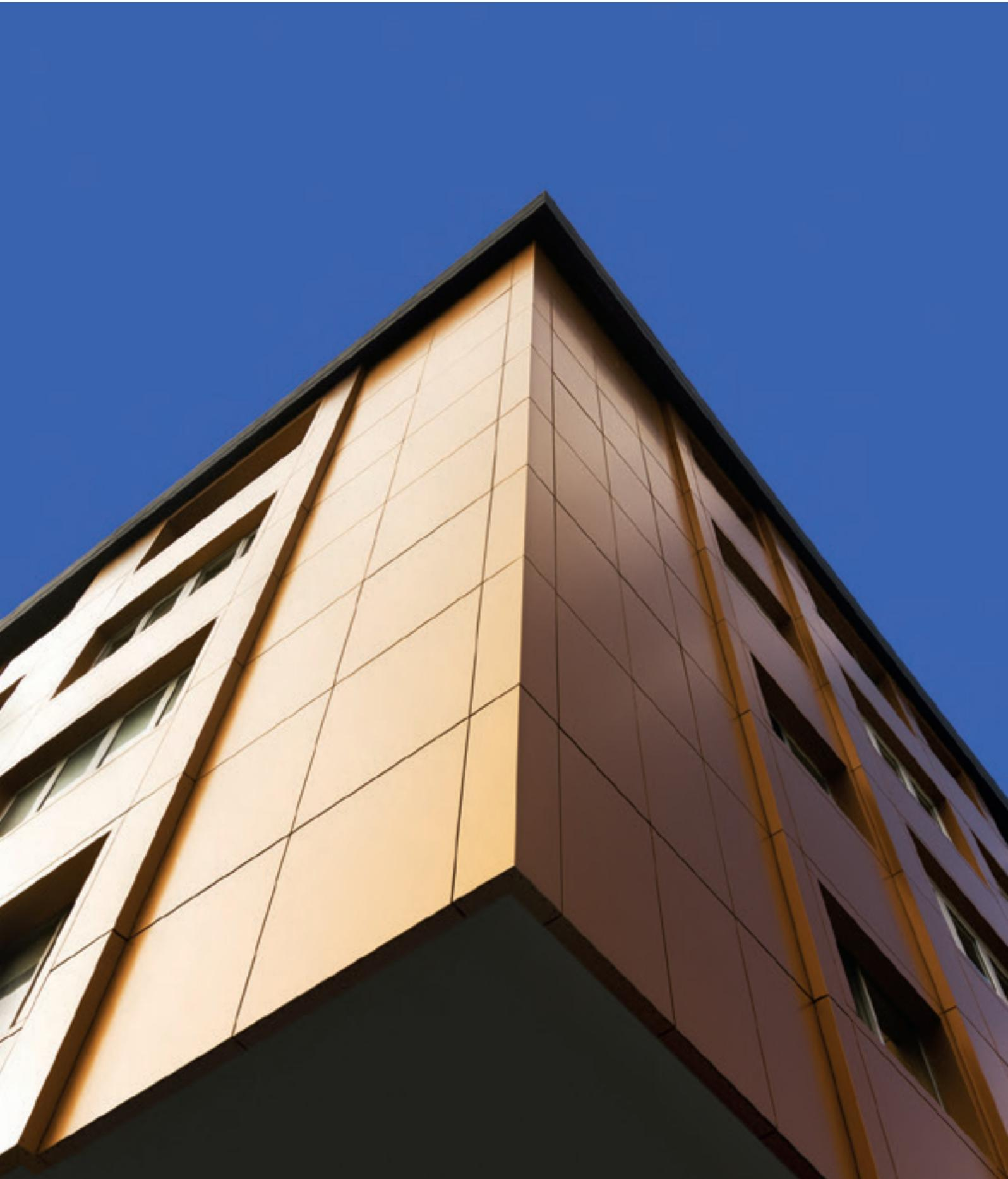
Buildbond FR es un panel composite, constituido por dos chapas de aluminio y un núcleo polímero y mineral retardante al fuego, de la clase "B – s1, d0", para situaciones en las que es necesario garantizar que no existe propagación de la llama en contacto con el fuego.
